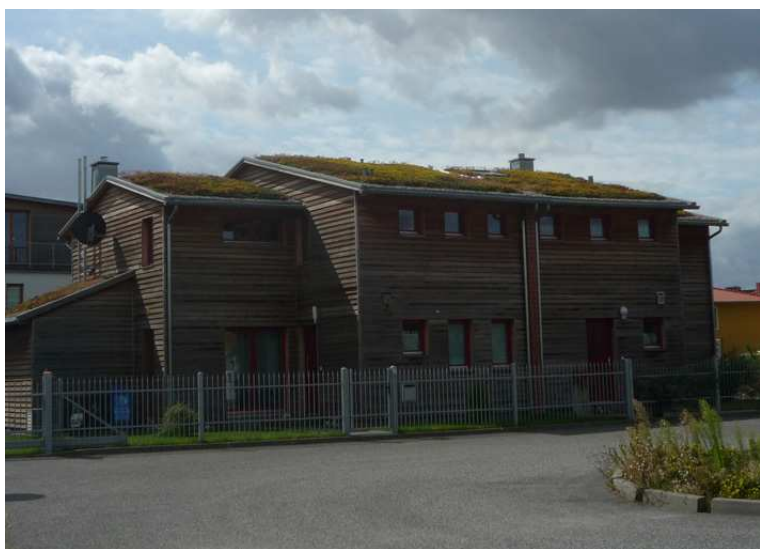
Fig.8a, b et c - Toiture maison jumelée – Ecolonia – Pays Bas, centre Solen et maisons privés à Berlin
