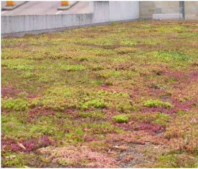
Fig.2 - Toiture parking parlement de Sarre – Allemagne
