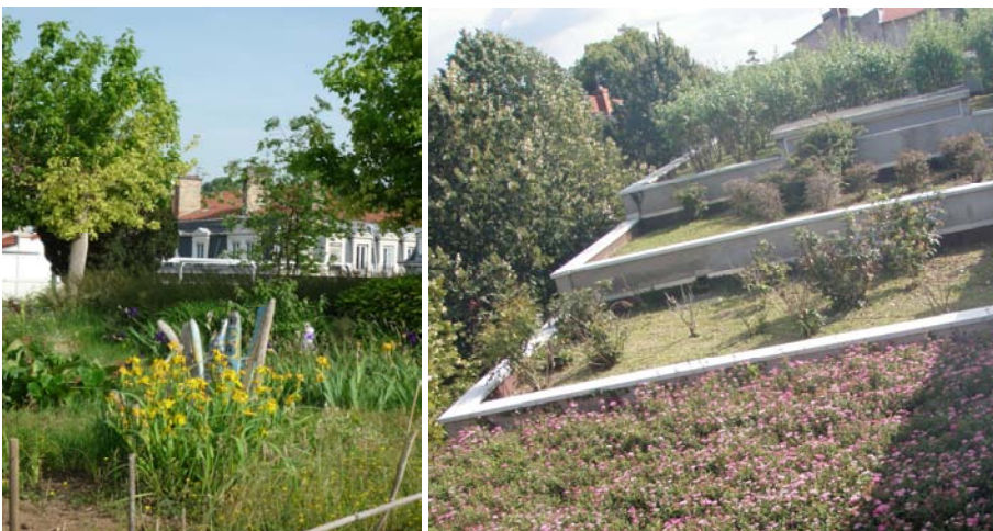
Lyon / Fig. 5b Toiture St Foy
