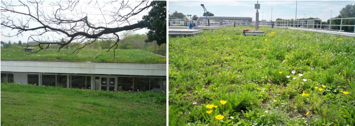
Fig. 4a - Toiture EML – Lyon / Fig. 4b Toiture STEP Feysine
